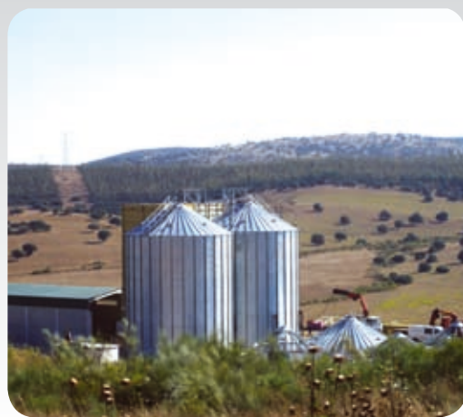
Fábrica de piensos en construcción en 'Las cumbres'
